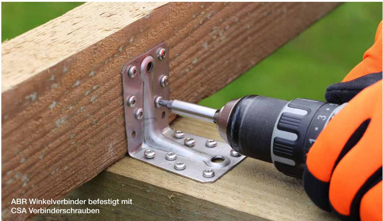
ABR Winkelverbinder befestigt mit CSA Verbinderschrauben
