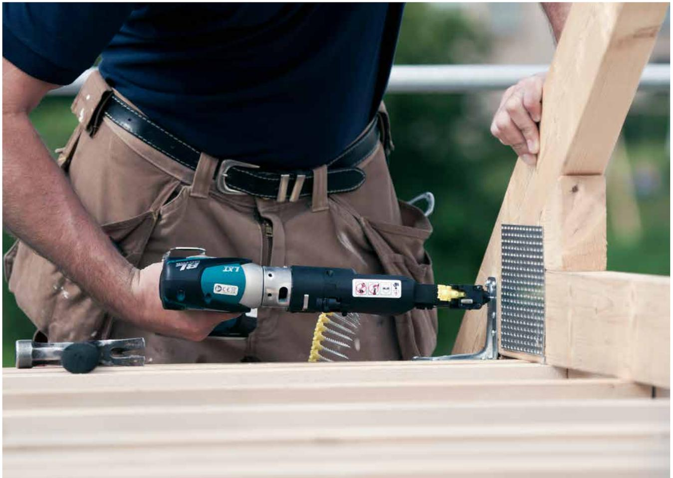
Montage eines ABR90 Winkelverbinders mit Quik Drive® Magazinschraubensystem. Weitere Holzverbinder finden Sie in unserem Profikatalog oder unter [strongtie.de](http://strongtie.de).
