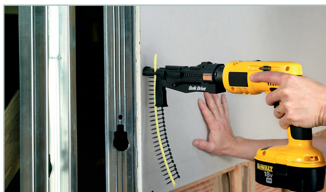
Montáž sádrokartonu na kovové sloupky
