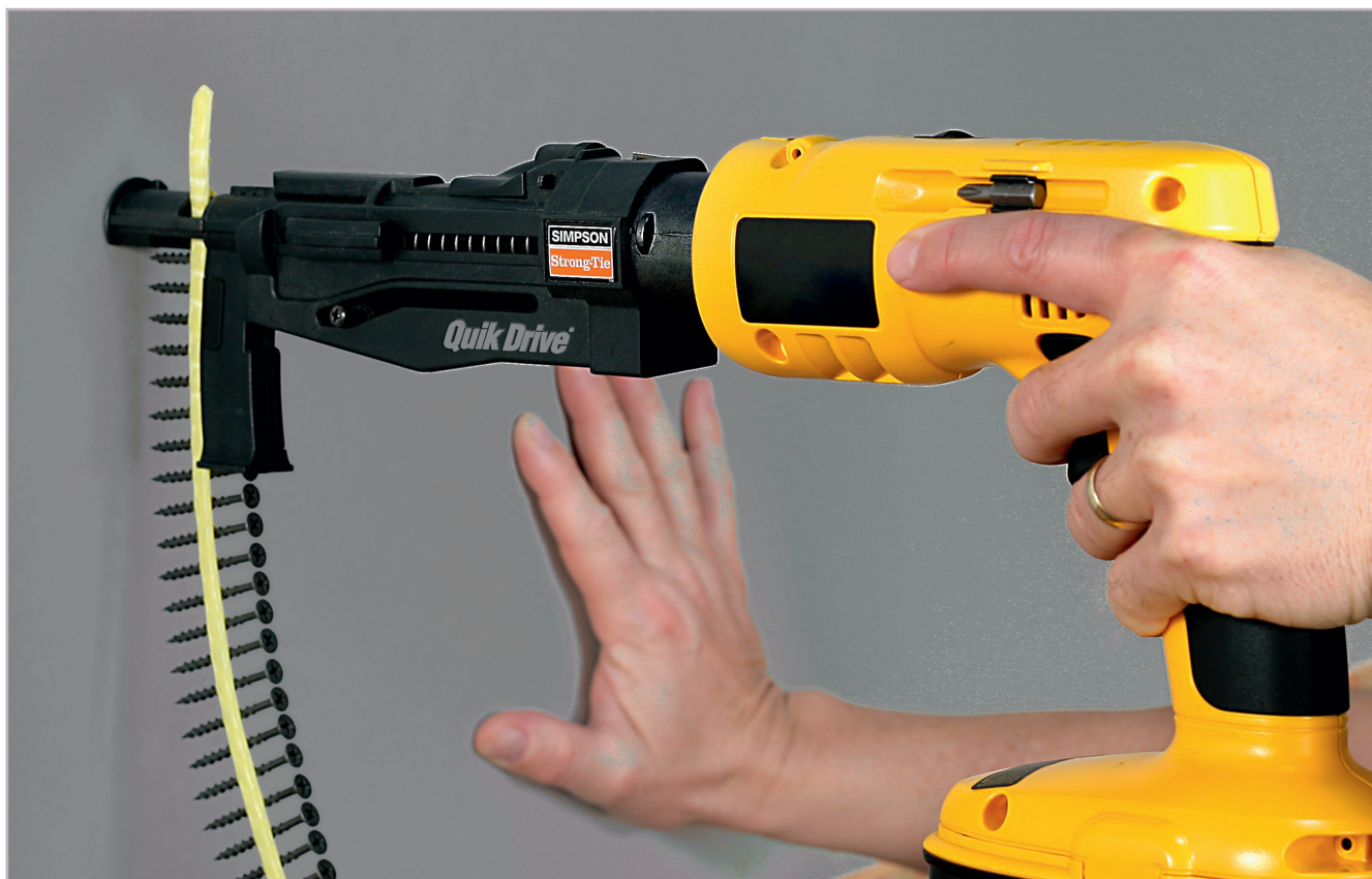
Montáž sádkokartonu na dřevěný rám pomocí DWC šroubů do sádkokartonu
